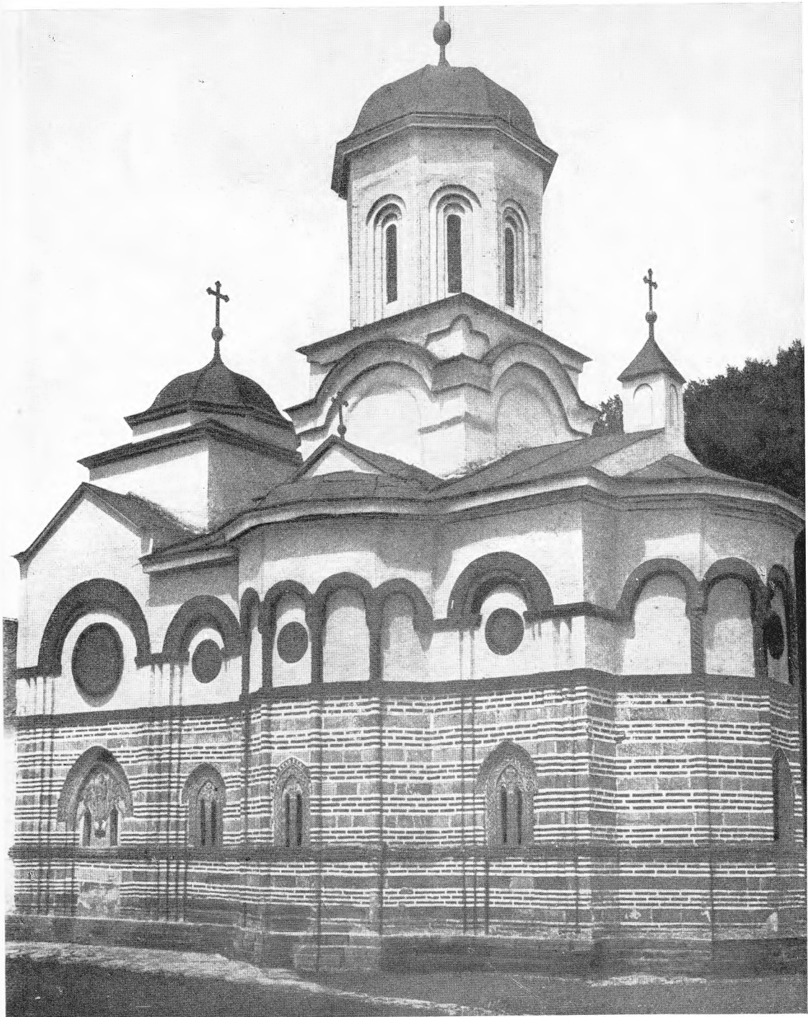
Abb. 9 Kalenic (Südostansicht vor der Restaurierung)
