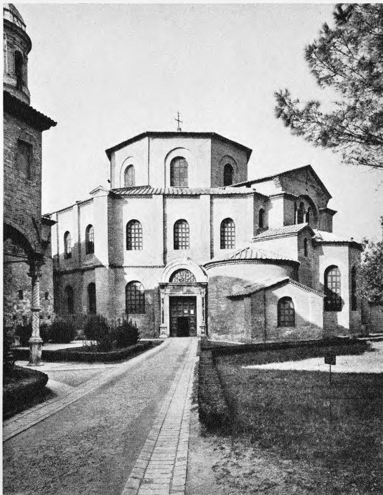
25 Ravenna. San Vitale. Zwischen 522 und 532 begonnen. Außenansicht
